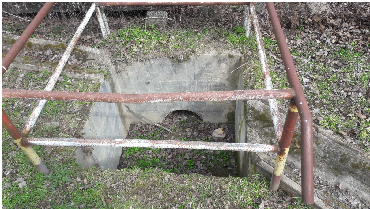
Obr. č.3 - Vývařiště pod propustkem č.1
